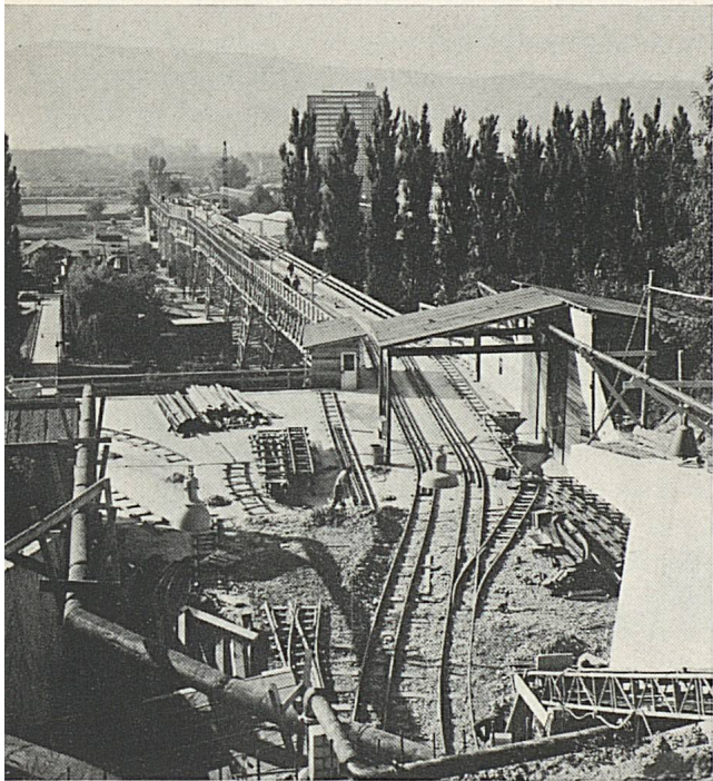
Die neue Linie Zürich Altstetten–Zürich Oerlikon erfordert den Bau eines 2118 m langen Tunnels durch den Käferberg. Das Bild links zeigt die Installationen am südlichen Tunnelende, das Bild rechts den Gewölbeausbruch über dem durch die Moräne vorgetriebenen Sohlstollen.
