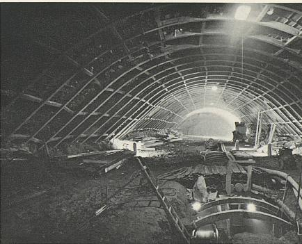
Die neue Linie Zürich Altstetten-Zürich Oerlikon erfordert den Bau eines 2118 m langen Tunnels durch den Käferberg. Das Bild links zeigt die Installationen am südlichen Tunnelende, das Bild rechts den Gewölbeausbruch über dem durch die Moräne vorgetriebenen Sohlstollen.
