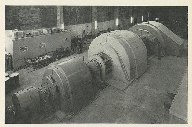
Neue große Umformeranlagen der Bundesbahnen – hier Rupperswil – ermöglichen den Austausch von Energiemengen und -leistungen mit dem Energienetz der allgemeinen Landesversorgung.
