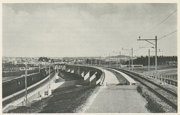
Kreuzungsbauwerke über die Autobahn Lausanne-Genf. Rechts die Zufahrt zu dem im Bau begriffenen Rangierbahnhof Lausanne bei Denges, links die Streckengeleise Lausanne-Morges-Genf (Brücken bei «Les Larges Pièces»).
