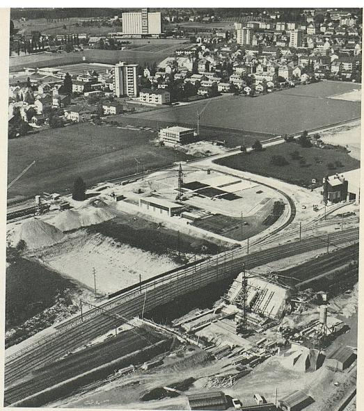
Bau einer Unterführung für die Nationalstraße N1 bei Wil (SG). Um den Eisenbahnbetrieb bei der Erstellung von Kreuzungsbauwerken so wenig als möglich zu beeinträchtigen und um ein unbehindertes Bauen zu ermöglichen, werden – sofern es die topographischen Verhältnisse sowie die Überbauung gestatten – die Streckengeleise provisorisch seitlich verschoben.
