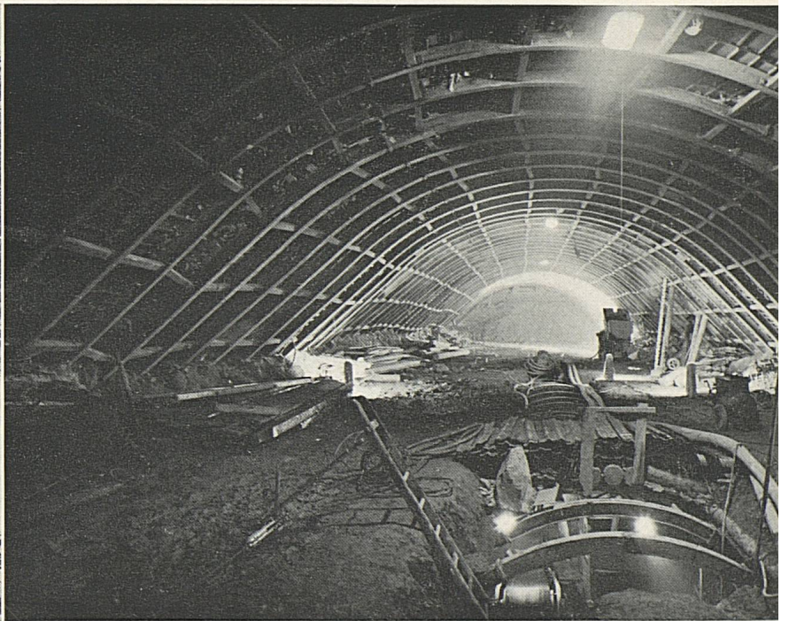
Die neue Linie Zürich Altstetten–Zürich Oerlikon erfordert den Bau eines 2118 m langen Tunnels durch den Käferberg. Das Bild links zeigt die Installationen am südlichen Tunnelende, das Bild rechts den Gewölbeausbruch über dem durch die Moräne vorgetriebenen Sohlstollen.
