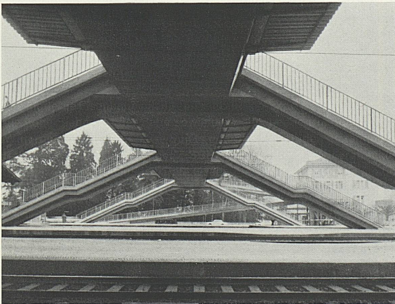
Die neue «freischwebende» Passerelle in Thalwil.
