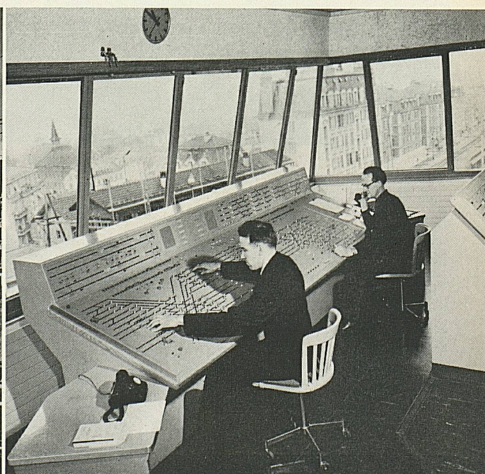
Im Bahnhof Lausanne konnte am 1. Dezember ein modernes elektrisches Gleisbildstellwerk in Betrieb genommen werden.
