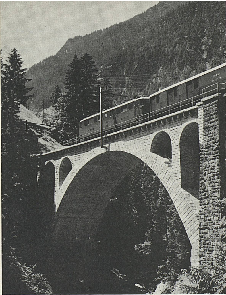
Auf der Gotthardlinie: Eine der neuen Betonbrücken mit Natursteinverkleidung
