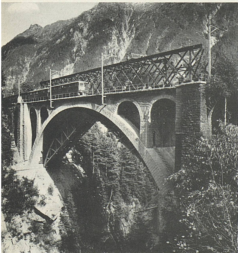
Auf der Gotthardlinie werden die eisernen Fachwerkbrücken zur Erhöhung der Tragfähigkeit in Betonbrücken mit Natursteinverkleidung umgebaut. Hier ist die mittlere Meienreuthbrücke im Umbau begriffen.
