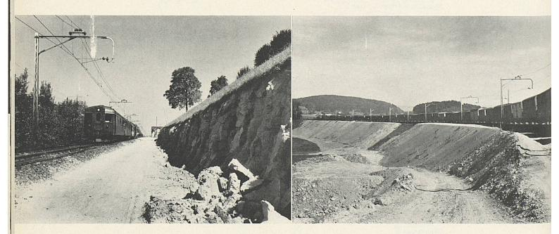
Am 29. Juni stimmte der Verwaltungsrat dem Projekt für die Bahnhoferweiterung Langenthal zu und stellte hiefür einen Kredit von 19,376 Mio Franken zur Verfügung. Die schon früher begonnenen Schüttarbeiten im neuen Güterbahnhof im Ausmaß von rund 100 000 m³ konnten abgeschlossen werden. Bereits wurden auch drei Zugs- und Abstellgeleise sowie das Ausziehgeleise beim Ablaufberg verlegt.
