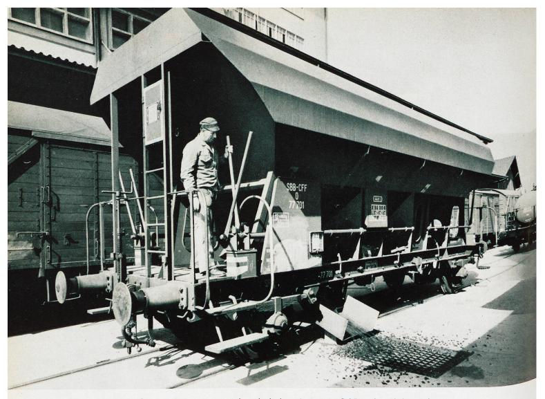
Beim neuen Selbstentladewagen für Kohle- und Kokstransporte kann das Ladegut direkt in eine Schüttgrube entladen werden
