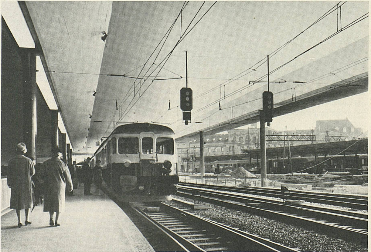
Der neue Perron 6 des Bahnhofs Bern steht in Betrieb
