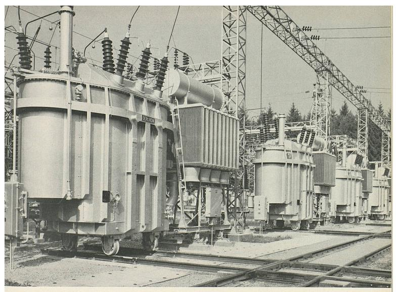
Im Unterwerk Rupperswil wurden, um die Kupplung zwischen dem 132 kV-Stammnetz und dem 66 kV-Verteilnetz zu verstärken, die alten Kupplungstransformatoren mit einer Gesamtleistung von 36 MVA durch die abgebildeten vier neuen Reguliereinheiten 138-114/66 kV mit einer totalen Leistung von 100 MVA ersetzt
