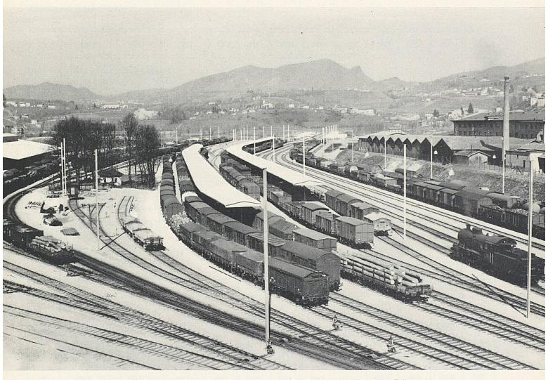
Ausbau der Bahnhofanlagen von Chiasso, 1. Bauetappe: Die teilweise erstellte Geleiseanlage der neuen Zollgruppe. Links im Hintergrund die neue Güterhalle, in der Mitte die überdeckten Zollrampen.
