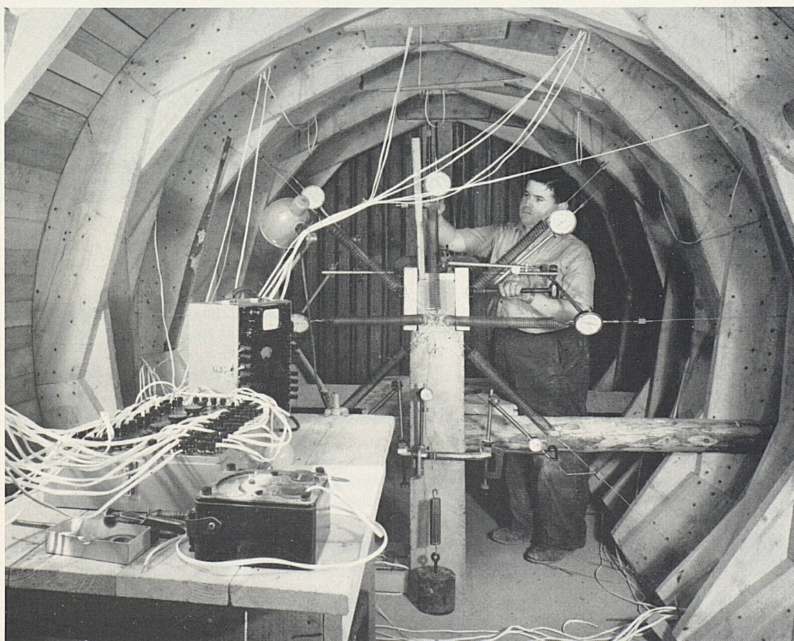
Messung der Beanspruchungen im Kabelstollen für die neue Stellwerkanlage des Hauptbahnhofes Zürich
