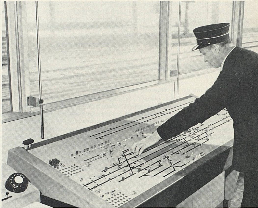
Der Betriebsbeamte bedient ein modernes Gleisbildstellwerk
