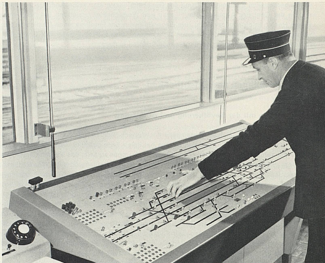
Der Betriebsbeamte bedient ein modernes Gleisbildstellwerk
