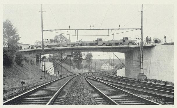
Effretikon: Die neue Strassenüberführung «Süd» wird einer Belastungsprobe ausgesetzt
