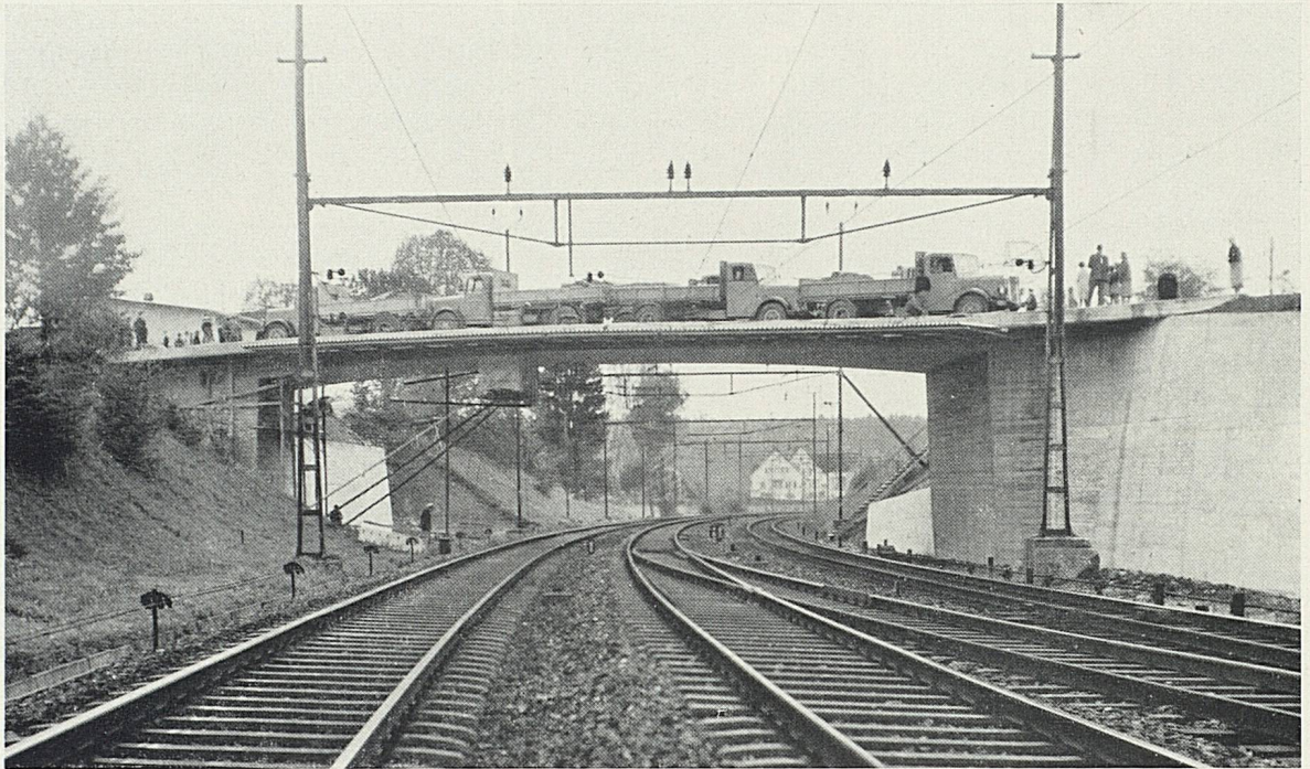
Effretikon: Die neue Strassenüberführung « Süd » wird einer Belastungsprobe ausgesetzt
