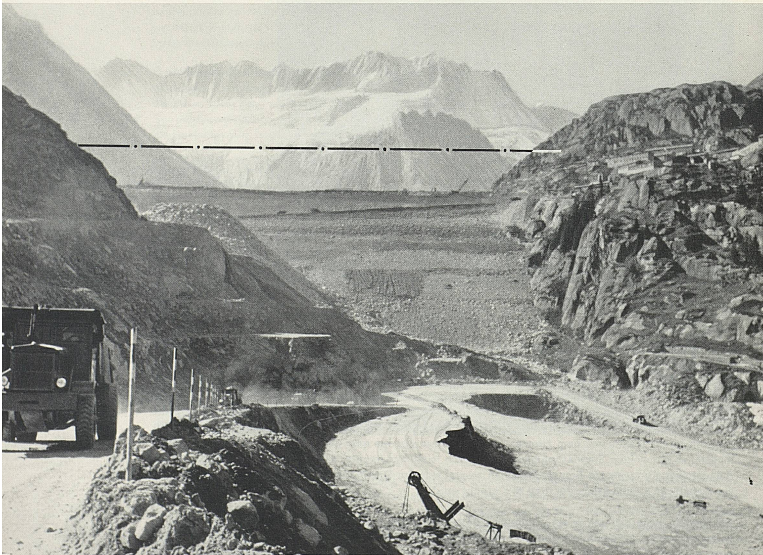
Staudamm des Grosskraftwerkes Göschenen. Blick von der Schutthalde gegen die luftseitige Dammböschung. Rechts oben das Barackendorf. Die punktierte Linie bezeichnet die endgültige Höhe der Dammkrone.
