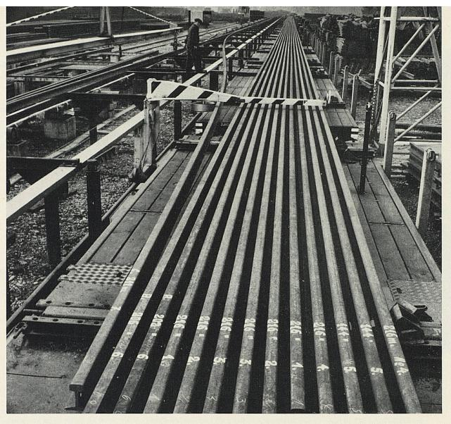
Durchgehend geschweisste Schienenstränge werden in der Schienenschweissanlage Olten verladen
