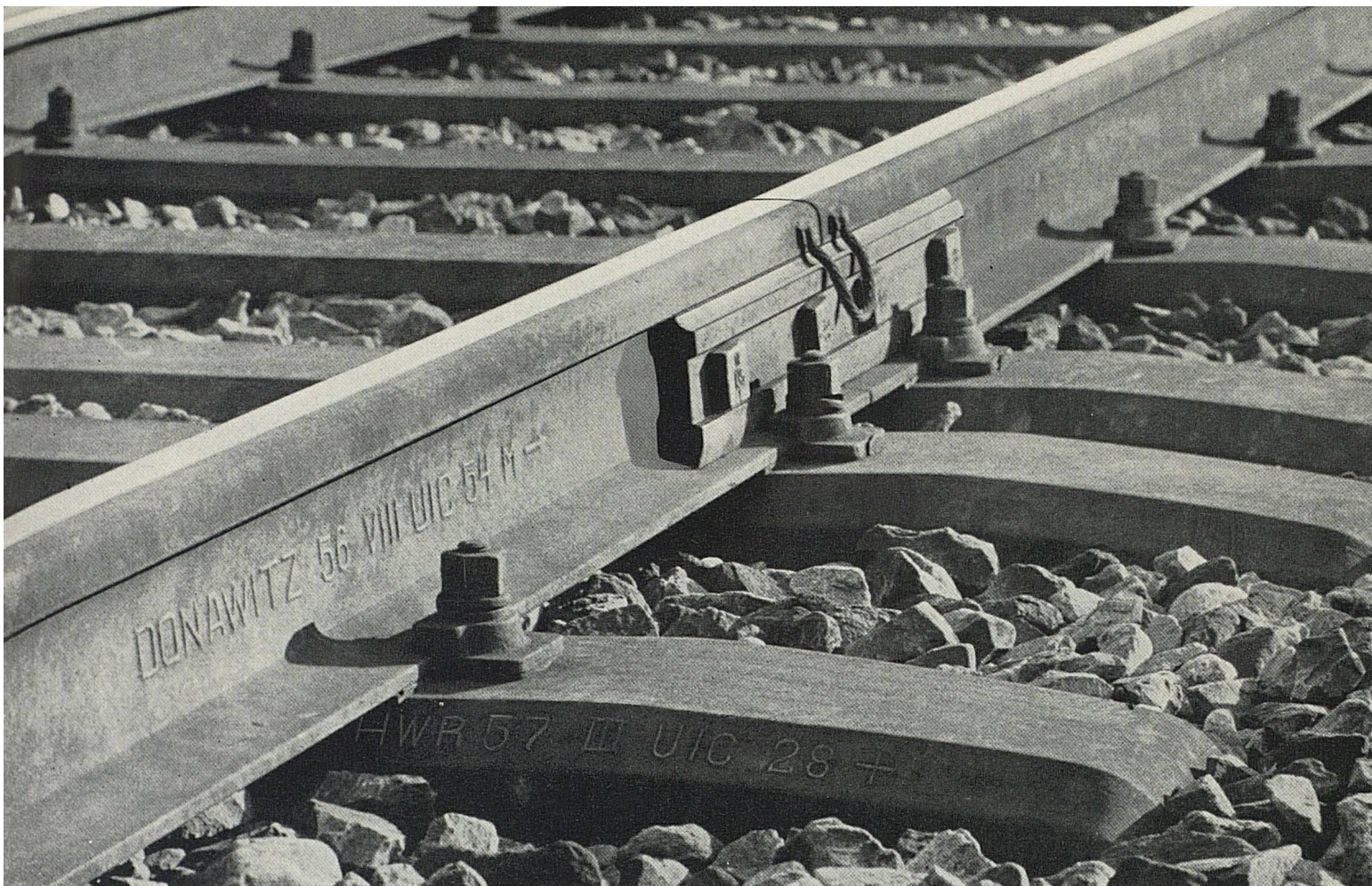
Oberbau «SBB III», Schienen- und Stahlschwellenprofil «UIC»
