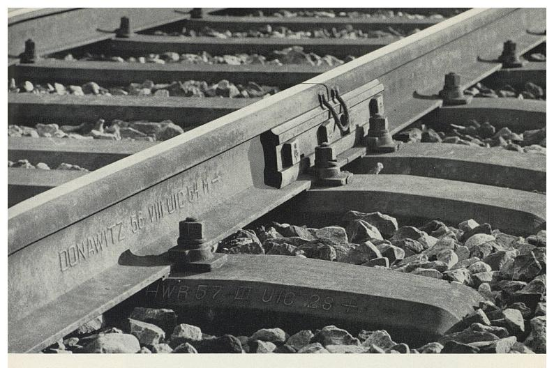
Oberbau «SBB III», Schienen- und Stahlschwellenprofil «UIC»
