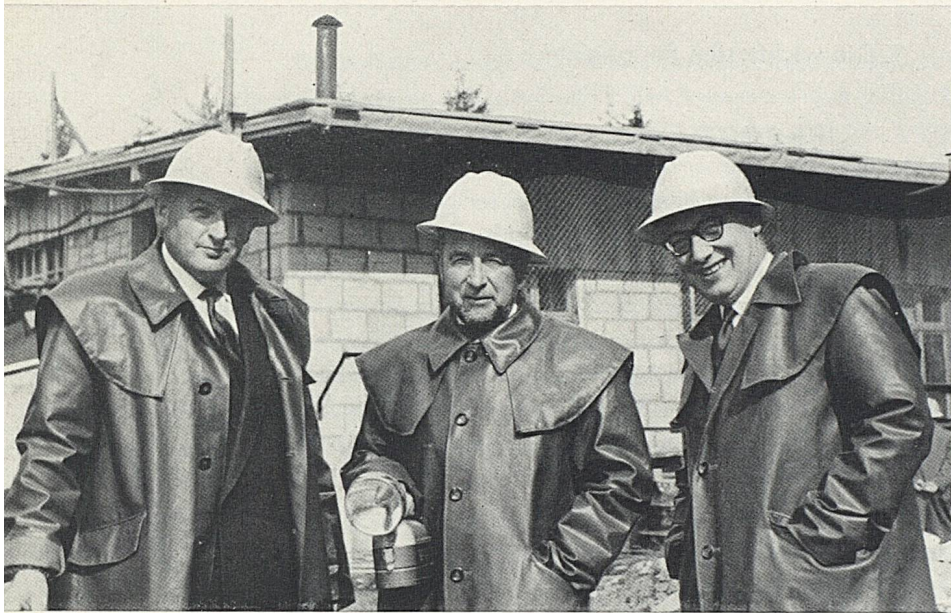
Bau eines 4 km langen, doppelspurigen Tunnels auf der Strecke Weesen-Mühlehorn (Walensee)
