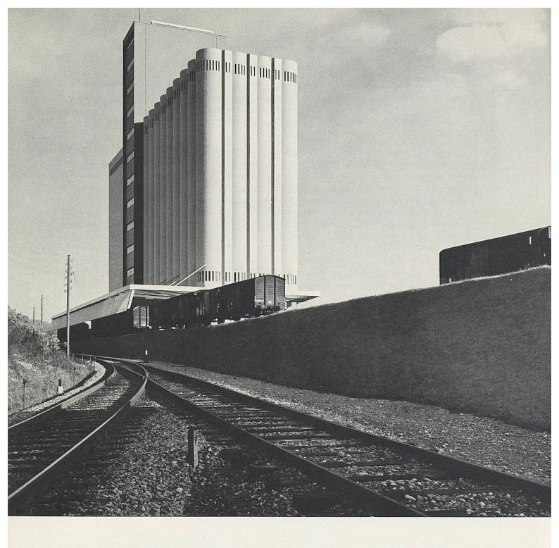
In Wil SG konnte der Getreidesilo nach einer Bauzeit von 22 Monaten am 1. September in Betrieb genommen werden. Mit einem Fassungsvermögen von 18 000 t ist er einer der grössten Silos des Landes. In bezug auf die maschinellen Einrichtungen (vor allem für die Pflege des Lagergutes) handelt es sich um die leistungsfähigste Anlage der Schweiz. Der Neubau wird oben im Bild gezeigt.
