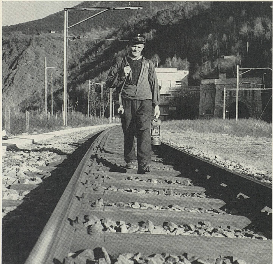
Vom Kontrollgang im Simplontunnel zurück
