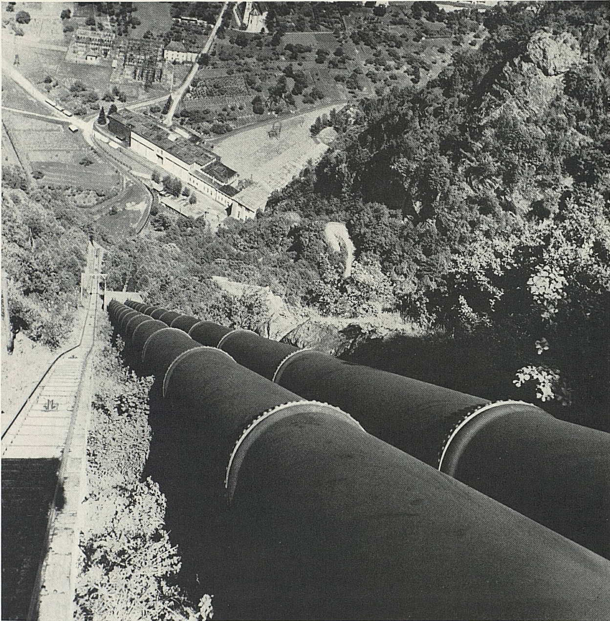
Druckleitungen des Kraftwerkes Vernayaz
