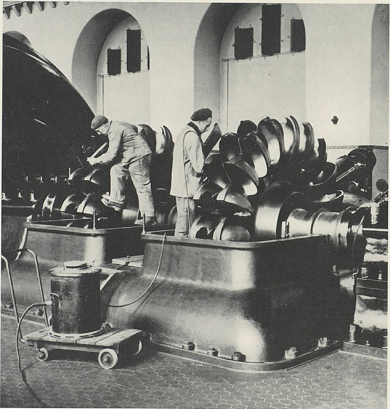
Unterhaltsarbeiten an einer Turbine im Kraftwerk Amsteg
