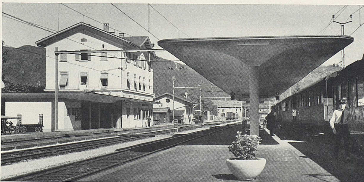
Die Station Maroggia-Melano als Beispiel einer nach neuzeitlichen Grundsätzen umgebauten Anlage
