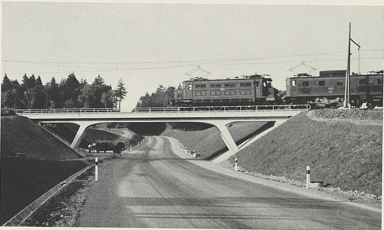
Die neuerstellte Unterführung in Andelfingen gestattet ein gefahrloses Kreuzen.
