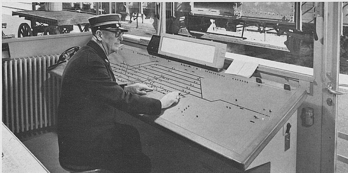
Der Bahnhofsvorstand bedient die modernste elektrische Stellwerkanlage mit Geleisebildstellpult
