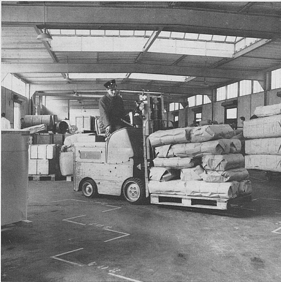
Einsatz eines Gabelhubtraktors in der Güterhalle Bern-Weiermannshaus
