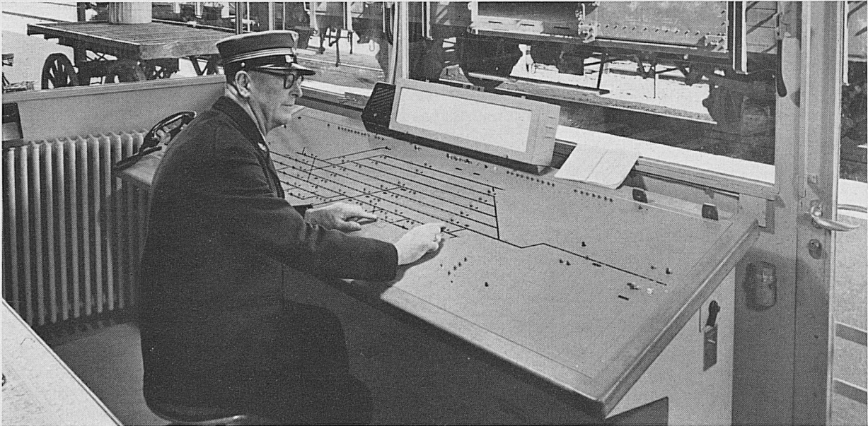
Der Bahnhofvorstand bedient die modernste elektrische Stellwerkanlage mit Geleisebildstellpult
