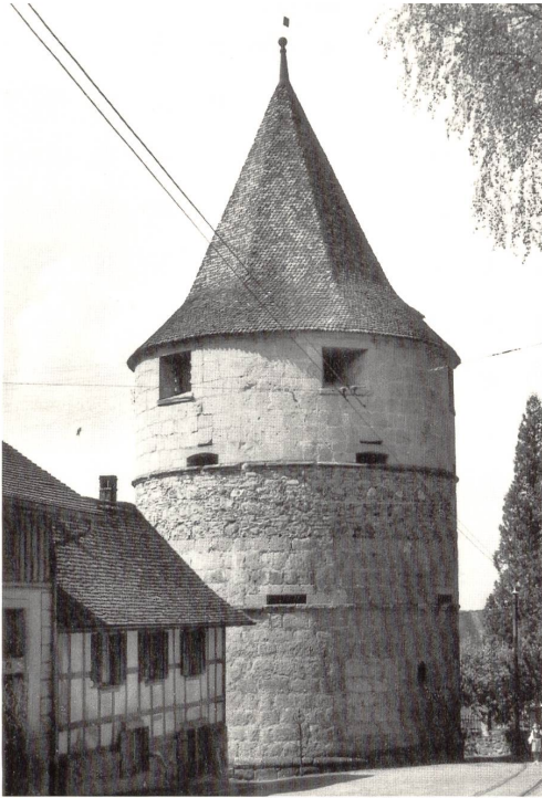
Abb. 15: Stadt Zug. Der ab 1522 von Ulrich Giger erbaute Pulverturm. Ansicht nach Westen, alte Aufnahme.
