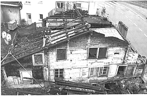
Abb. 15: Schwyz, Haus Nideröst, Abbau des Hauses im November 2001.
