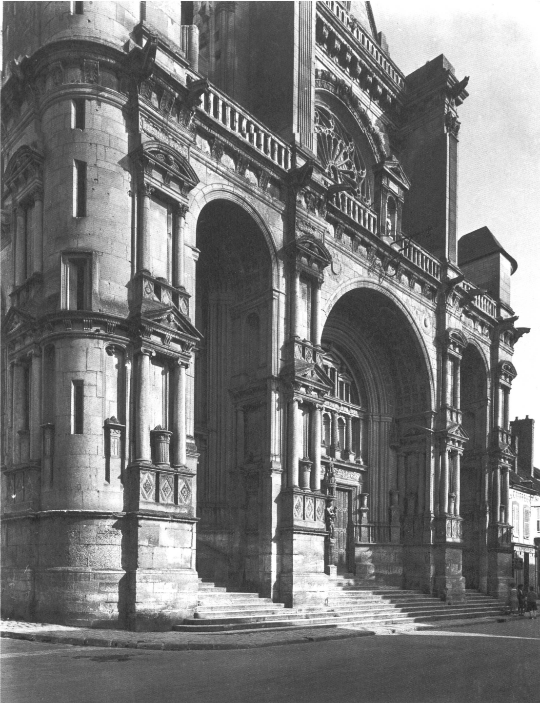
Abb. 6: Villeneuve-sur-Yonne, Pfarrkirche Notre-Dame, Westfassade (Foto 1940/44).
