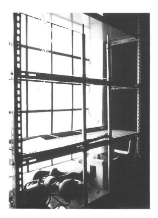
Fig. 4.2. Behelfsmäßige Meßeinrichtung in Othfresen. Als Auflager dienten die zwei senkrechten, an das Metallgestell gebundenen Zeltstangen. Die Halmstücke wurden wie in Fig. 4.1. hinter die Stangen gehalten. Sobald mit der Federwaage etwas Kraft ausgeübt wurde, verhinderte die Reibung das Herunterfallen des Halmes, so daß er losgelassen werden konnte.
