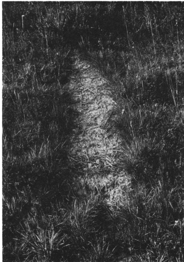
Abb. 14. Ständig feuchte Stelle auf der Böschung Wagenhausen. Eine undurchlässige tieferliegende Bodenschicht bewirkt, dass ständig Wasser austritt, was Pflanzenwuchs praktisch verunmöglicht.
