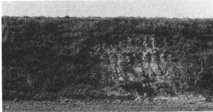
Abb. 15. Abgerutschtes Böschungsstück bei Wagenhausen. Die Vegetation an dieser Stelle war relativ dicht. Das abgerutschte Material ist bereits wieder auf die Böschung gebracht worden.
