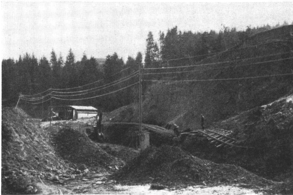
Abb. 11. Schieferkohlenabbau in Gondiswil-Hüswil in der östlichen Fuchsmatt. Unter der Rollbahn das Schieferkohlenlager, darüber mächtige Schichten von sandig-lehmiger Beschaffenheit mit Kohlenbändern, vorn rechts eingestürzt. Phot. W. Lüdi 4. X. 1941.
