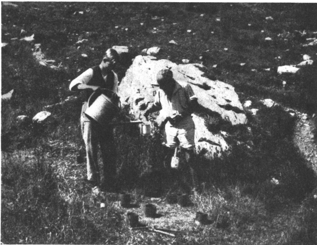
Abb. 23. Sickerversuch in Dauerfläche 38. Fünf Sickerzylinder sind in den Boden eingeschlagen; das Wasser (1 Liter pro Zylinder) wird eingefüllt.
