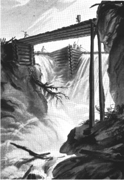
Abb. 10. Schwellenwerk im Gadmenwasser zum Auszug des Flössholzes. Errichtet 1770 durch Bergherrn Friedrich Walter.
