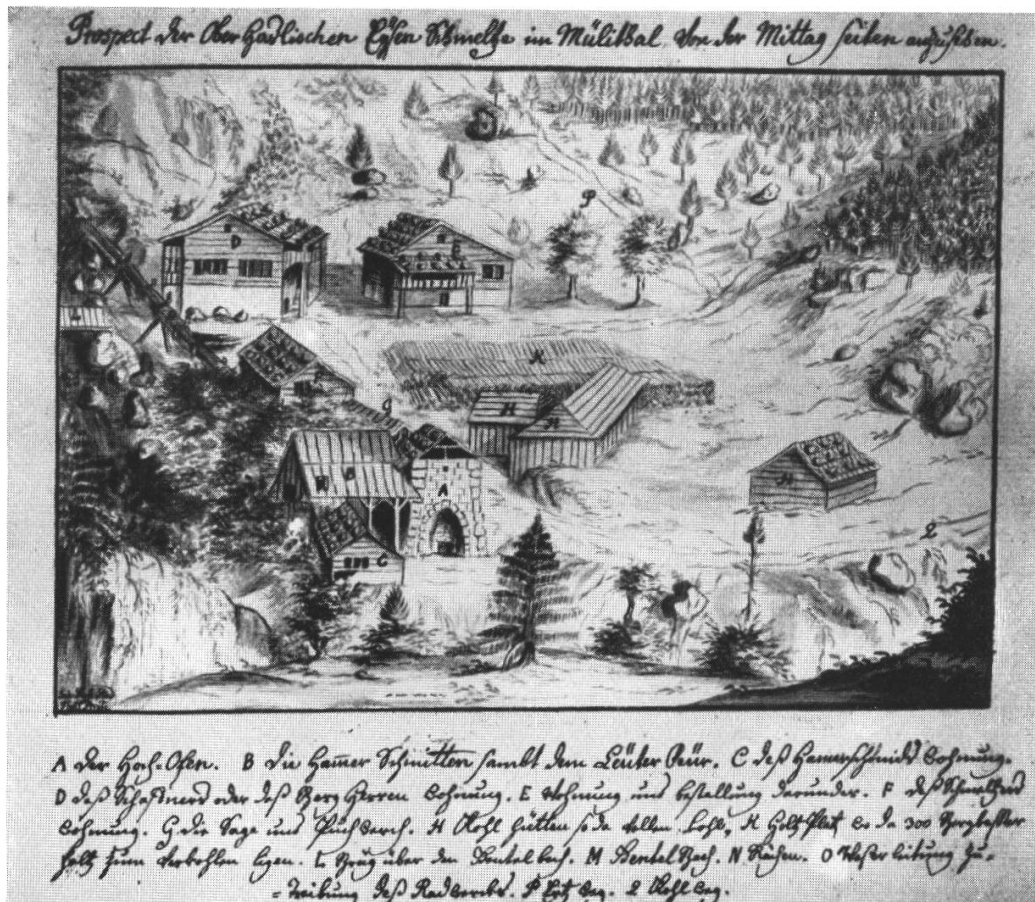
Abb. 8. Das Bergwerk im Mühletal nach einer Bleistiftzeichnung (Format 12×17 cm) zu einem Bericht über das Bergwerk aus dem Jahre 1760 (Cahier Nr. 2).
