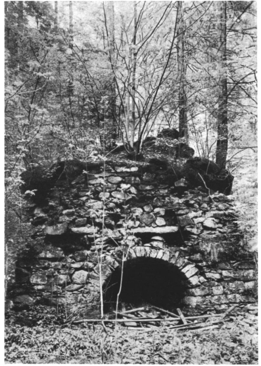
Abb. 11. Schmelzofen im Schmelzwald zwischen Zweilütschinen und Lauterbrunnen (Grundriss 7 \times 7 m, Höhe 5 m).
