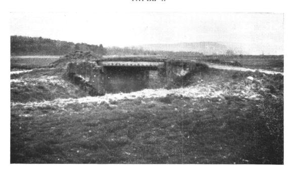
Abb. 6. Brücke über den Stegmattenkanal bei Müntschemier (im alten Aarelauf). Zeigt das starke Einsinken des Torfbodens. phot. Lüdi.
