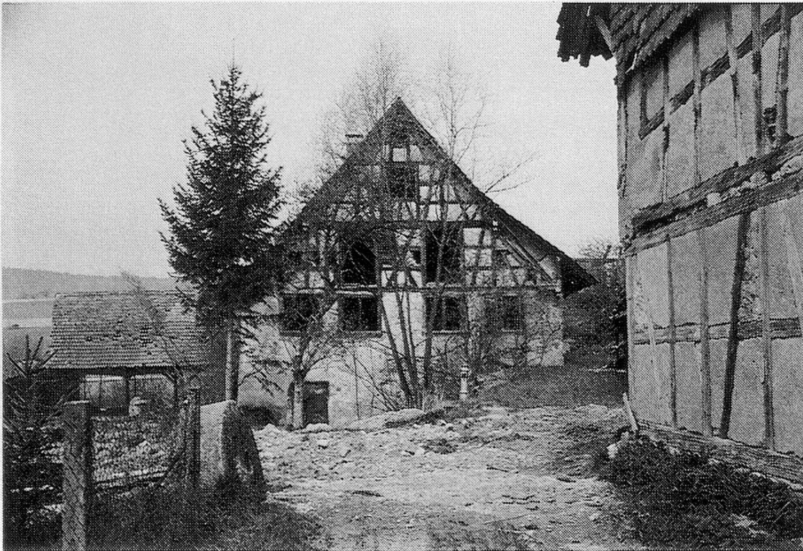
Abb. 6 Wohnhaus der alten Mühle in der Tiefenwaag in Unterehrendingen AG, Aufnahme aus Richtung Osten vom Dezember 1978 (Foto Paul Kofel, 5442 Unterehrendingen AG)
