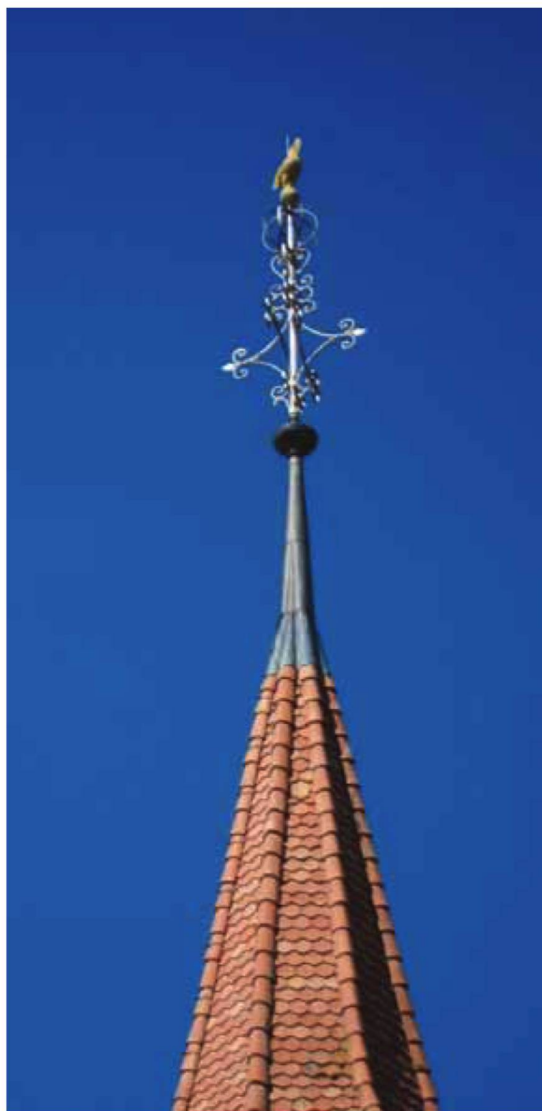
Image 3: Flèche du clocher de l'église de Cernier (commune Val-de-Ruz), construite par Jean-Jacques Lorimier, posée le 20 mai 1776.
