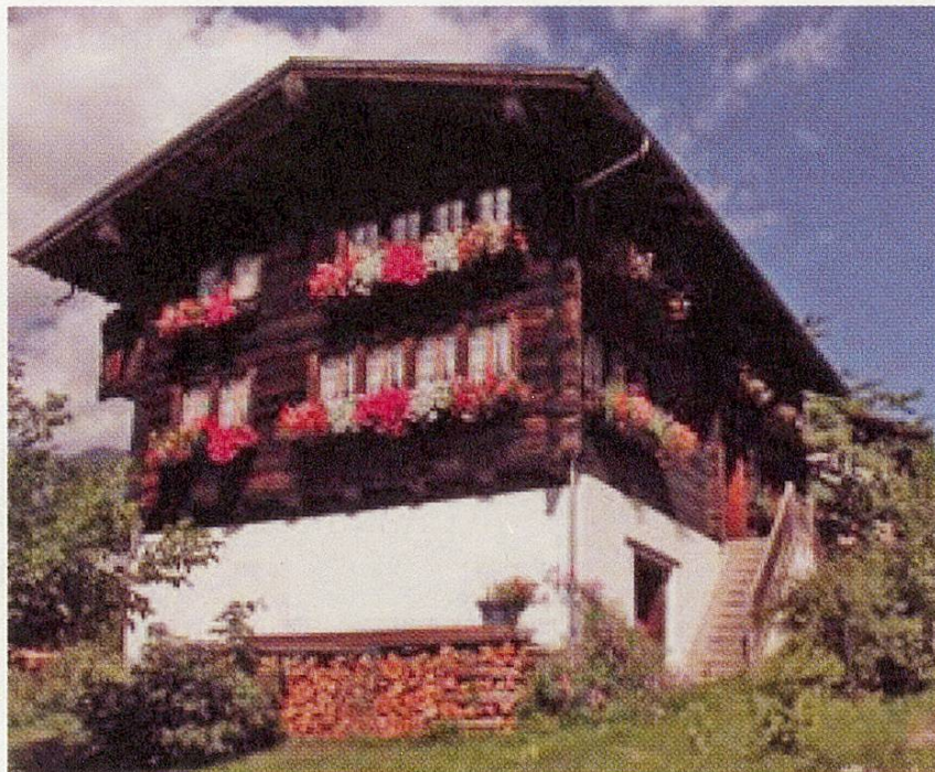
Fig. 5: L'ancienne « Huberhaus », datée de 1558, passa à la famille Niggeli au XIXème siècle. Elle appartient toujours à ses descendants. (Photographie C. W. Flisch).
