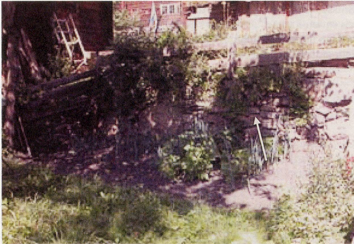
Fig. 4: Emplacement de l'ancienne maison Niggeli dans laquelle vécut Josef Ignatz Niggeli (1808-1892) jusqu'à l'incendie qui la détruisit entièrement. Elle se trouvait au-dessus de la « Huberhaus » (voir texte). Seul un pan de mur du soubassement subsiste encore ; ses pierres délimitent aujourd'hui un jardinet (flèche). (Photographie C. W. Flisch).
