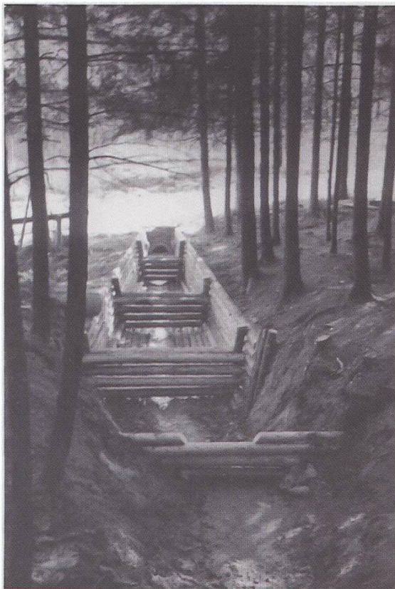
78 Otelfingen, Geschiebefang Sarenbach beim Waldaustritt an der Ellenbergstrasse, 1935
