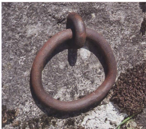
73 Otelfingen, Ring für Umlenkrolle an Stützmauer Ellenbergstrasse von 1935
