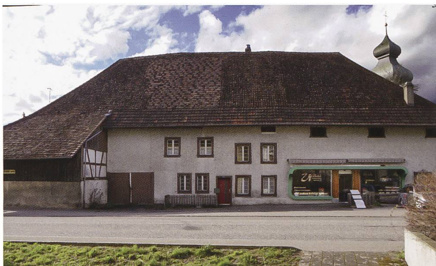
14 Die ehemalige Chilemetzg an der Schulstrasse
