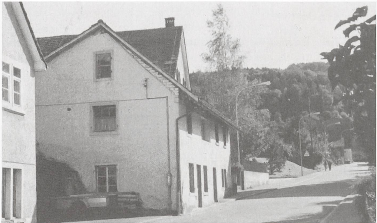
8 Die Milchannahmestelle an der Dorfstrasse
