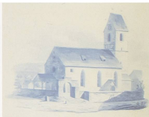
Abbildung 31: Die 1555 gebaute Kirche Otelfingen um 1837 (Quelle: Kirche Otelfingen-Boppelsen-Hüttikon. Zum Kirchenjubiläum 1607–2007. Zeichnung von Ludwig Schulthess)
