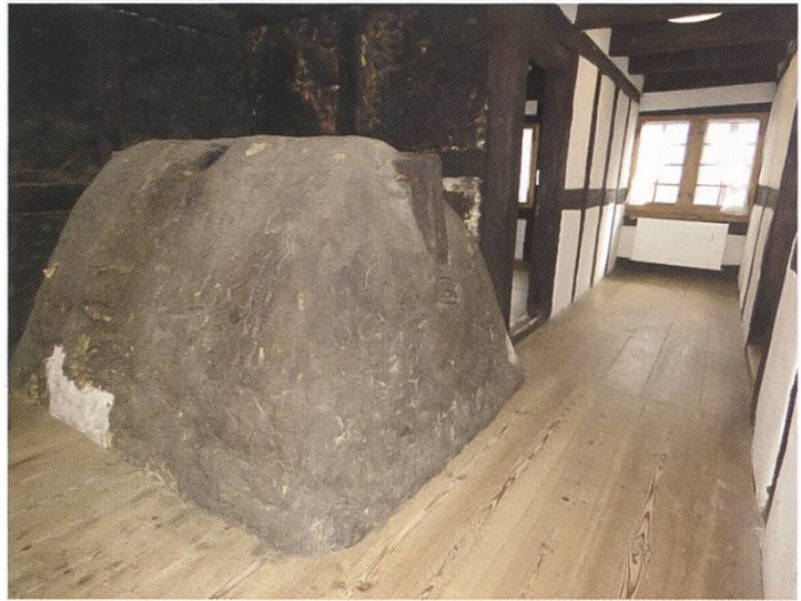
Abbildung 19: Chämihütte im oberen Stockwerk (Foto: Sabine Moser-Schliier)
