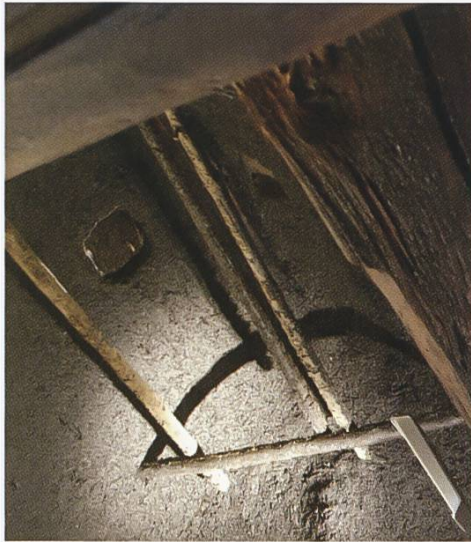
Abbildung 18: Die russgeschwärzte Chämihütte in der Küche mit Sicht nach oben (Foto: Sabine Moser-Schliier)
