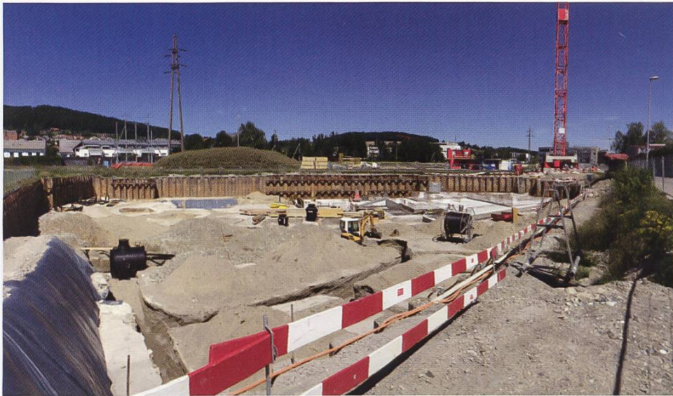
Die Baustelle der Seniorenresidenz Buchs im August 2017
