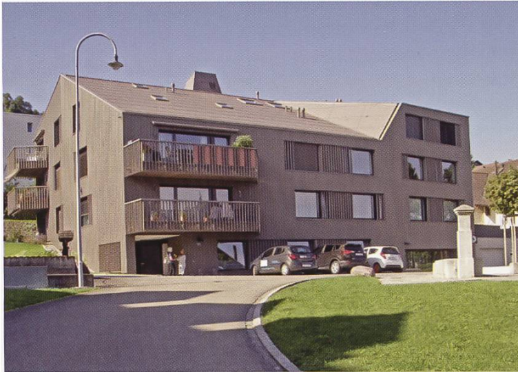
Alterswohnungen «Sagi» am Mühleweg in Regensdorf
