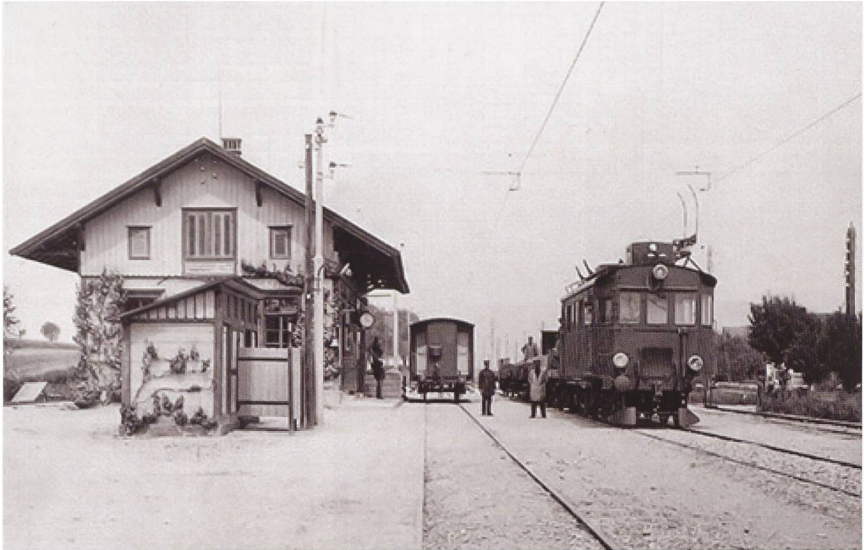
Bahnhof Regensdorf, um 1906. Elektrischer Versuchszug mit Rutenfahrleitung (Schweizerische Eisenbahnrevue 12/1991)
