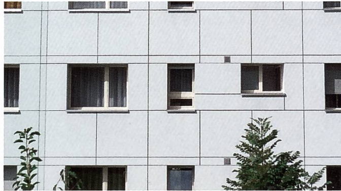
Sanierung der Fassaden mit Fassadenelementen, welche die Fugenteilung nach den Fensteröffnungen richten (Photo H.R. Meier)
