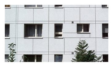
Sanierung der Fassaden mit Fassadenelementen, welche die Fugenteilung nach den Fensteröffnungen richten (Photo H.R. Meier)
