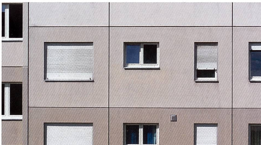
Fassadenausschnitt der Igeco-Elemente mit einfach ausgeschnittenen Fensteröffnungen und zurückhaltenden Farben für Fensterrahmen und Rafflamellen (Photo H.R. Meier)
