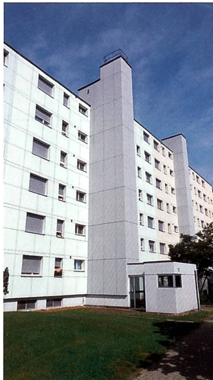
Sorgfältig gewählte neue Fassadenplatten mit Anlehnung an die ursprüngliche Fugenteilung (Photo H.R. Meier)
