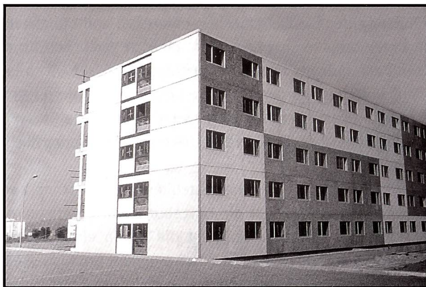
Standardisierte Wohnbauten in Plattenbauweise in der ehemaligen DDR (Photo Peter Steiger)
