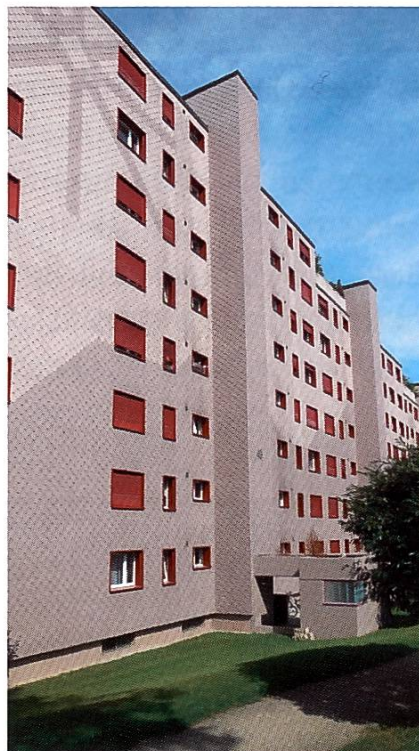
Missratene Fassadensanierung mit dem diagonal verlegten roten Schuppenpanzer ohne Gliederung und ohne Farbabstufungen (Photo H.R. Meier)
