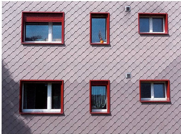
Neue Fassadenverkleidung nach der Sanierung mit einem rötlich gefärbten Schuppenpanzer (Photo H.R. Meier)
