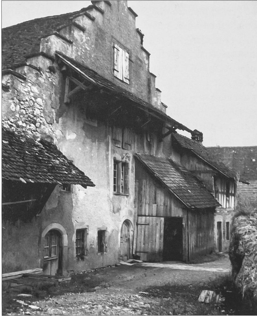
Bild 6b: Blick in den Mühlehof auf Mühlegebäude, 1964
