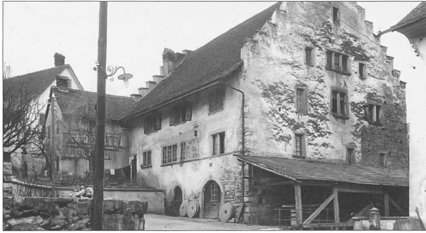
Bild 4: Aufnahme von Südosten 1928
