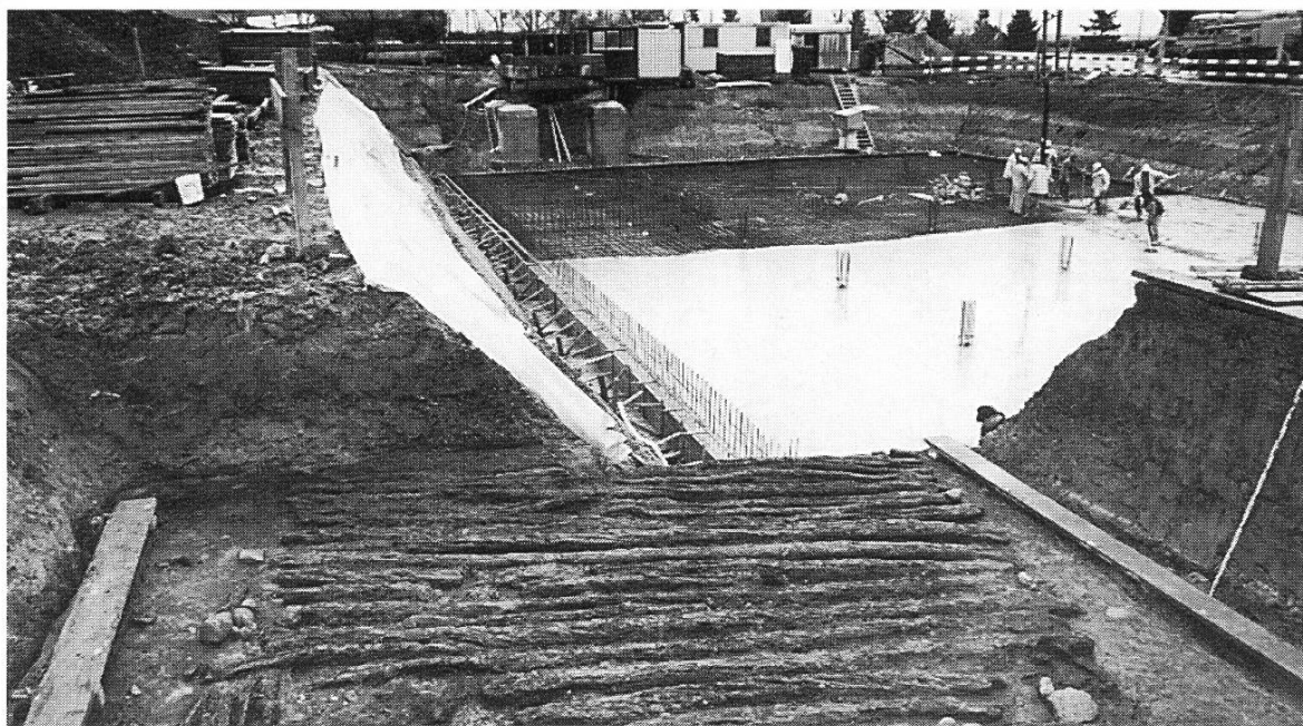
Abb.2. Otelfingen, Lauet. Blick nach Osten auf die Prügellage aus Eschen- und Erlenstämmen. Im Hintergrund die bereits ausgehobene Baugrube, in welcher die Fortsetzung der Strasse unbeobachtet blieb.
