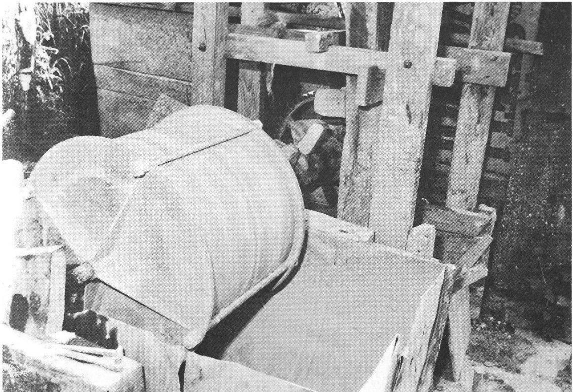
Abb. 12 Die Mischtrommel zum Mischen verschiedener Lehmqualitäten.
