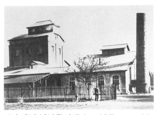
Abb. 3 Die Steinfabrik Watt. Im Vordergrund die Naturstrasse zwischen Regensdorf und Watt. Neben dem Hochkamin das Kesselhaus. Im Hochbau war die Kalkbrennerei untergebracht.
