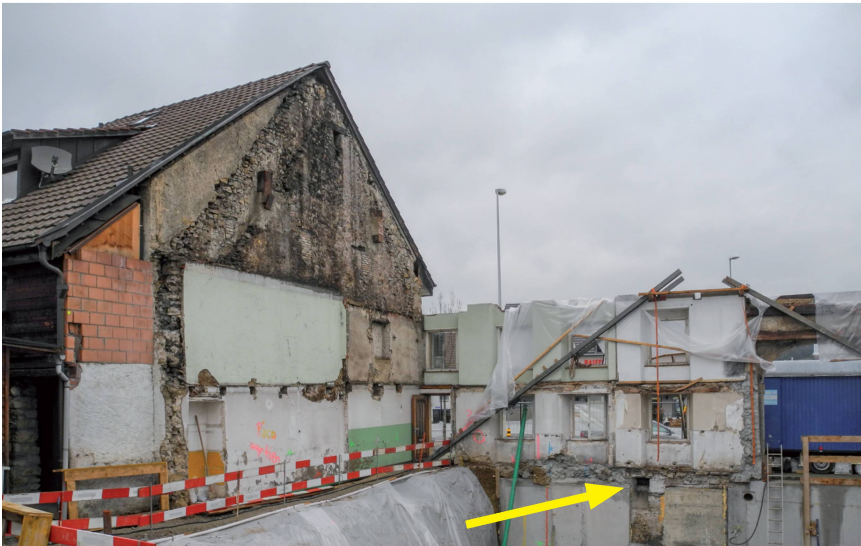
Abb. 5 Die Auskernung von Gebäude 34 eröffnete interessante Einsichten zur Baugeschichte. Rechts die Fassade aus den 1850er-Jahren mit Haustüre, sieben Fenstern und ganz rechts der Teil des Korbbogens als Scheuneneingang. Die unterschiedlichen Wandfarben lassen Schlüsse auf die Raumeinteilung zu. Das Kellerfensterchen (gelber Pfeil) stammt vom Vorgängerbau.
