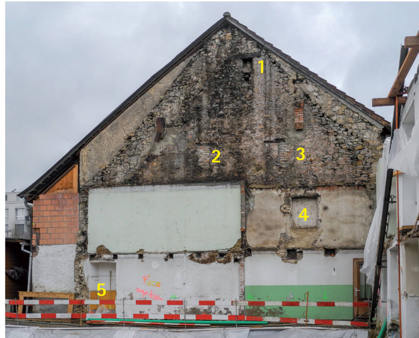
Abb. 6 Die älteste Giebelmauer von Haus Nr. 34 von innen. 1: von aussen zugemauerte Maueröffnung, durch die der Küchenrauch abzog. 2, 3: ganz zugemauerte Lichtöffnungen zur Belüftung des Dachbodens (alter Begriff: Füllbünli). 4: das einzige von wahrscheinlich vier von aussen zugemauerten Fenstern in der Giebelfassade. In diesem Raum ist noch der ursprüngliche Verputz vorhanden. 5: von aussen zugemauerte Türöffnung, die von der Küche in den Garten führte.
