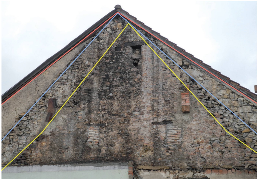
Abb. 7 Am Giebel von Haus Nr. 34 lassen sich drei Bau- phasen ablesen. Gelb: Die Dachlinie des strohgedeckten Gebäudes, das nach 1806 durch Brand stark beschädigt wurde. Blau: Dachlinie des wieder aufgebauten Gebäudes. Rot: Dachlinie der Vergrößerung um 1850 (rechts) und des Anbaus von Gebäude 32 im Jahr 1874 (links).
