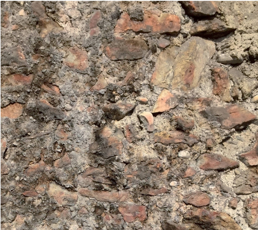
Abb. 8 Deutliche Brandspuren am Mauerwerk des Nordgiebels von Nr. 34.
