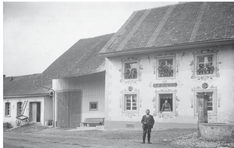
Werkstatt-Anbau am Wohnhaus mit Malereien der späteren Eigentümerfamilie Mösch.
