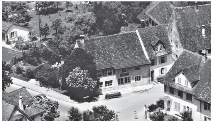
Blick auf die Mitte der 1970er-Jahre abgebrochenen Gewerbebauten an der Einmündung der Kaistenbergstrasse in die Hauptstrasse.
