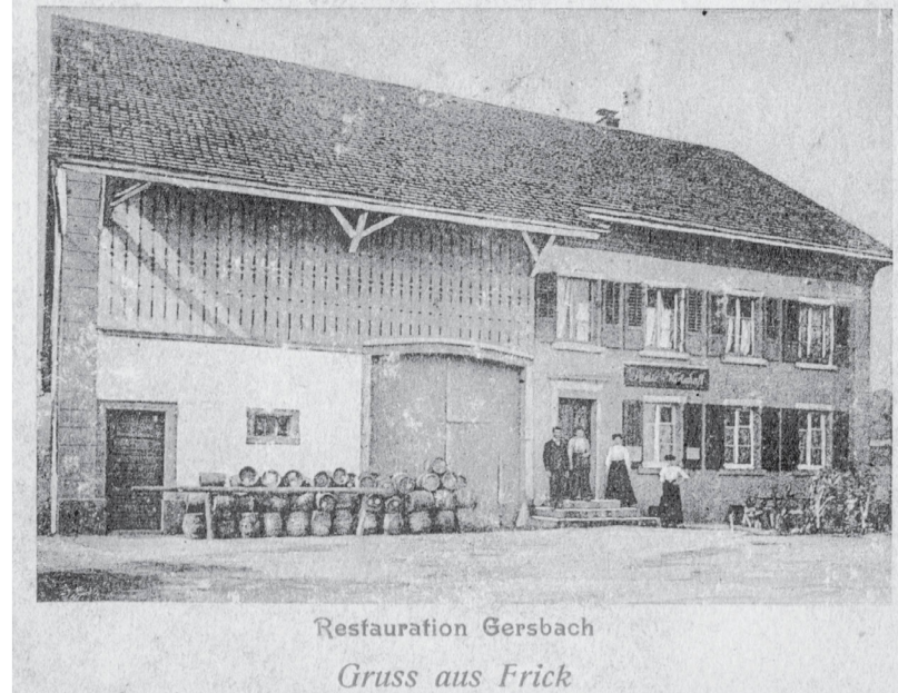
Ziegelei am neuen Standort und Restauration Gersbach (heute «Kaschmir») auf einer Ansichtskarte von 1905.
