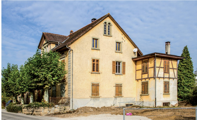
Nach dem Umzug an die Bahnhofstrasse: Gebäude Schuma-cher vor dem Umbau 2017.
