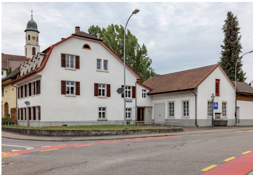
Die Gebäude der ersten «Müller»-Generation in der Verzweigung Schulstrasse/Geissgasse.
