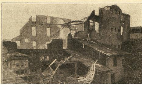
Das 100 m lange und 20 m breite Werkgebäude Ro. 1, in dem viel Holzwerk, das zur Formung und Trocknung der Ziegel Verwendung fand, aufgestapelt war, brannte vollständig aus. Unfer Bild zeigt die Brandruinen mit den eingestürzten Dachern.
