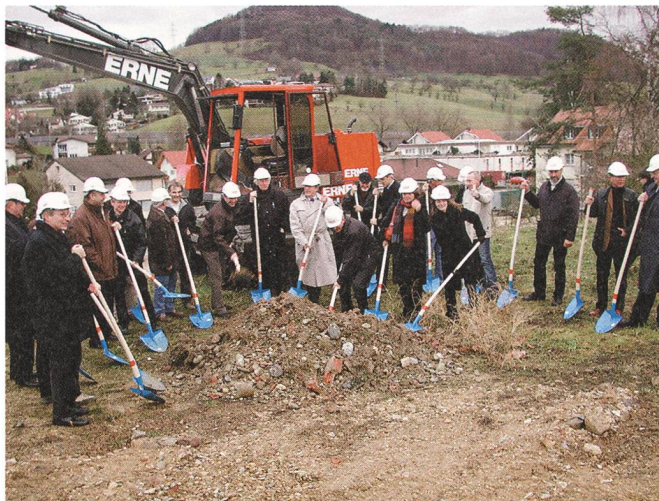
Spatenstich für das Zentrum Mitteldorf.
