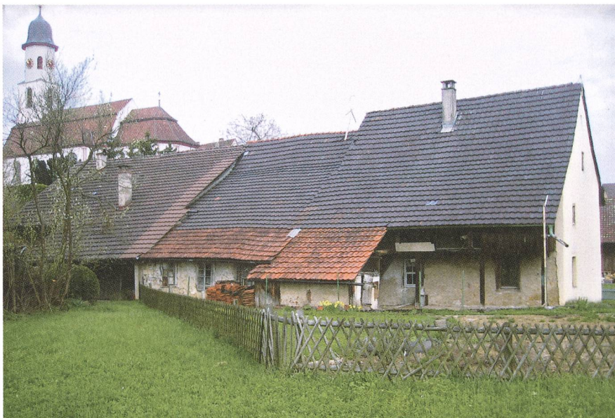
Ansicht der Hinterhofseite. Im 19. bis 20. Jahrhundert baute man südseitig (Nr. 5) eine Wagnerei, einen Schweinestall und einen Abort an. Die Dachfläche reichte dadurch immer weiter herab und nahm dem Wohnteil sehr viel Tageslicht.
