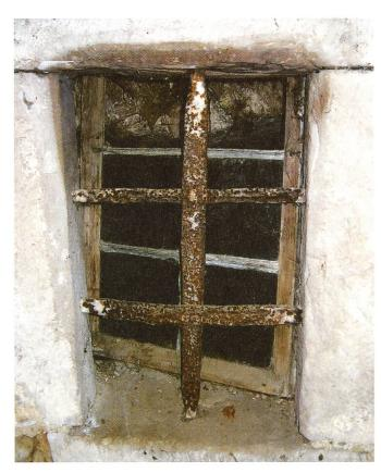
Vergittertes, spätgotisch profiliertes Fenstergewände mit bleiverglastem Fenster. Gewölbekeller des Nachbarhauses Nr. 7.
