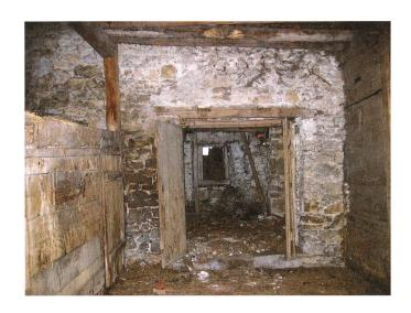
Haustyps aus der Mitte des 18. Jahrhunderts noch nicht. Möglicherweise bildete diese Ausmauerung einen zusätzlichen Brandschutz, bevor der Einbau des Kamins Vorschrift wurde.<sup>4</sup>
